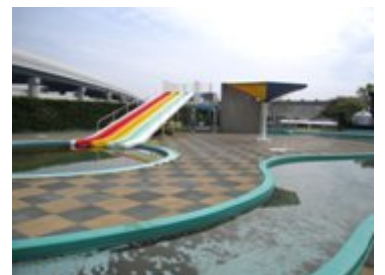
市民プールの様子
