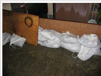
土嚢での浸水対策が行われている現場を確認
